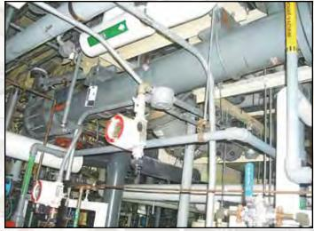
METAULLICS SYSTEMS CO. L.P. (CARBORUNDUM) IMPERVIOUS GRAPHITE SHELL AND TUBE HEAT EXCHANGER
