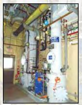
MISONIX MDL. MVS-25650 AND 15650 75/500 SCFM GAS SCRUBBER
